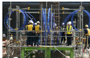
基礎杭施工の様子
