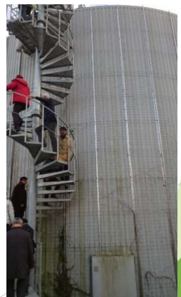
(写真：冷水蓄熱タンク)
