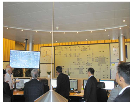
(写真：CTR中央監視室)
