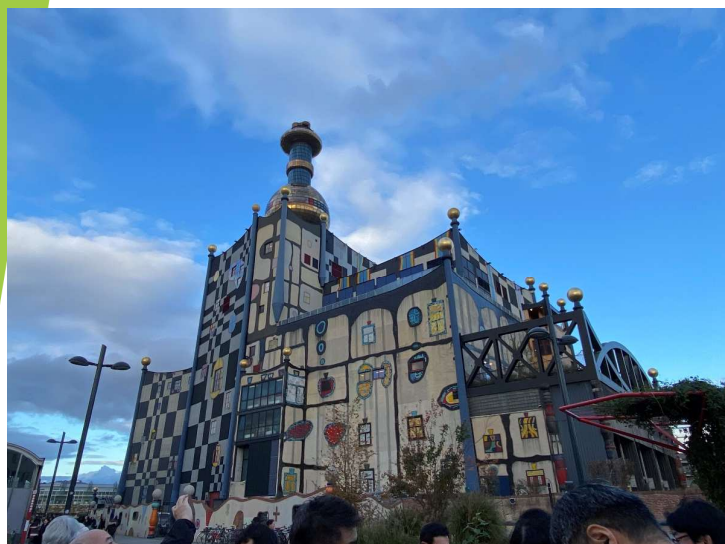
シュピテラウごみ焼却場 (写真)
