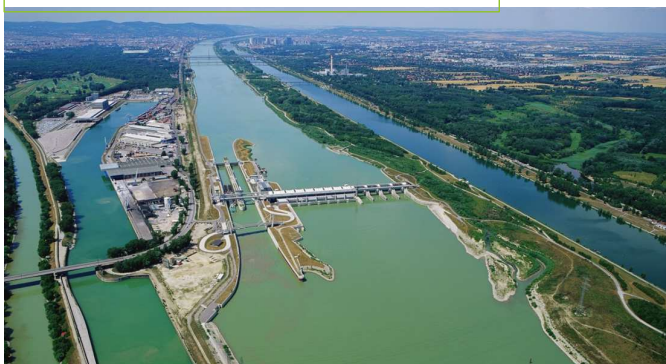
フロイデナウ水力発電所 外観
