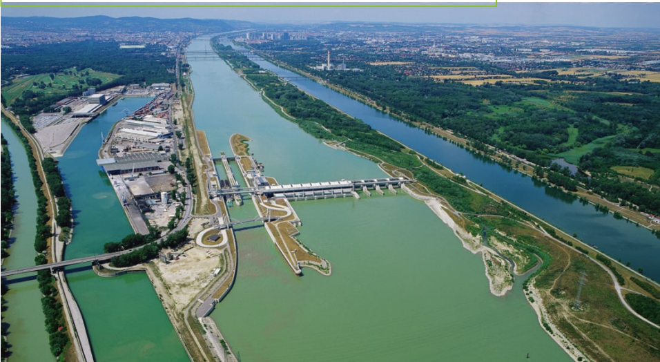
フロイデナウ水力発電所 外観
