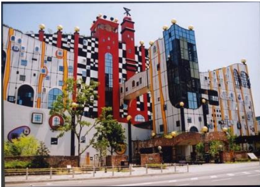
大阪広域環境施設組合 舞洲工場 (出展：HP)
