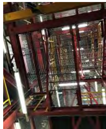
図 4.3.3-2 見上げると床材はメッシュ仕上げ(写真)
