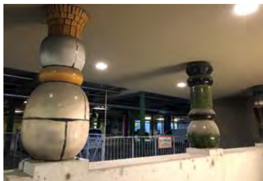
図 4.3.3-10 駐車場の柱までモザイクタイル貼り(写真)
