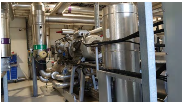
図 2.4.3-1 ヒートポンプ(左)と蓄熱槽(右)(写真)
