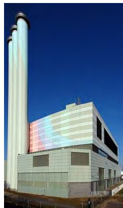
図 3.4.1-4 熱電併給プラント ノッセナーブリッケ(写真)
