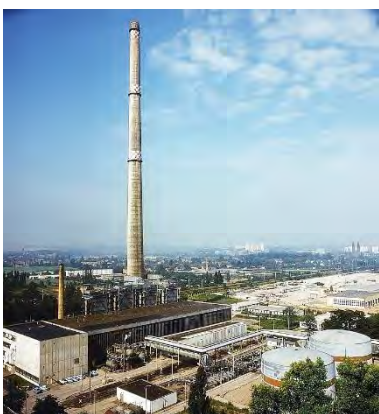
図 3.4.1-3 ドレスデンライク熱供給プラント(写真)
