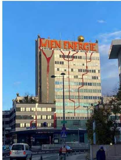
図 4.3.1-4 隣接する WIEN ENERGIE ビル(写真)
