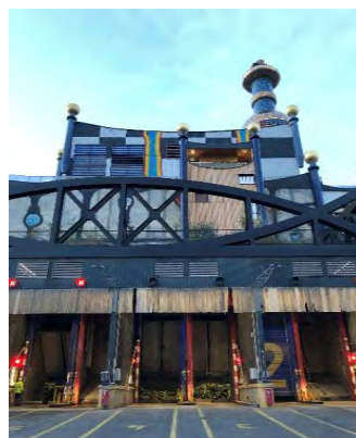
図 4.3.1-6 ゴミ搬入口(写真)
