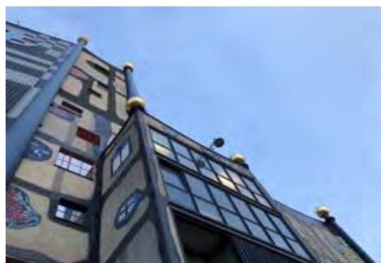
図 4.3.3-9 焼却場壁面(写真)
