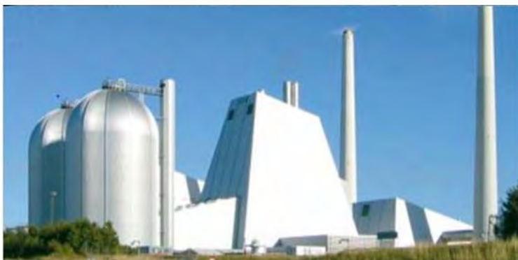
図 2.2.4-2 Avedøre Plant にある大規模蓄熱タンク、2×24,000 m 3 、最高温度 120°C、圧力差 10Bar
