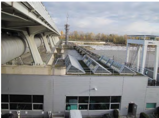
図 4.2.3-1 フロイデナウ発電所(写真)
