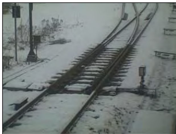
図 3.6.1-5 線路凍結防止の活用の様子(写真)
