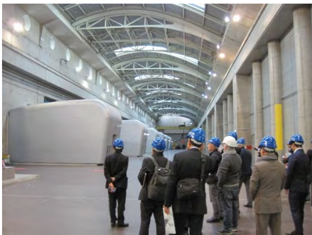
図 4.2.3-3 マシンホール(写真)
