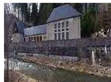
図 3.4.1-5 ドルフハイン水力発電所(写真)
