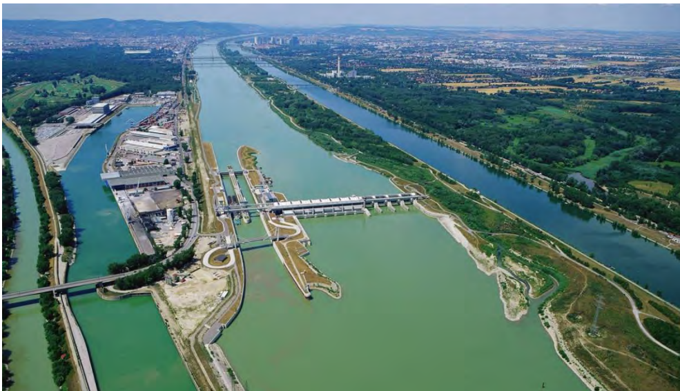
図 4.2.2-1 フロイデナウ水力発電所の全景(写真)
