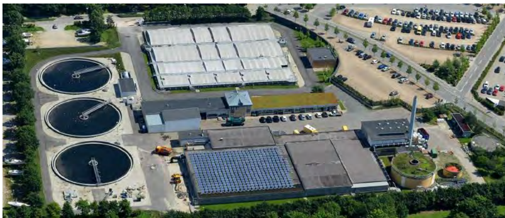
図 2.3.4-1 施設外観(写真)
