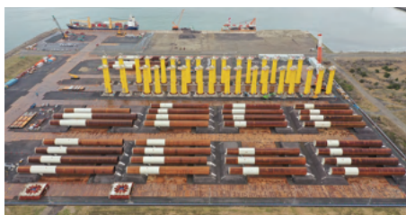
基礎部材(モノパイル、トランジションピース)が搬入された秋田港飯島ふ頭(2021年4月) (写真提供:秋田洋上風力発電(株))
