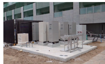
マンションに設置された純水素型燃料電池 (工事中)
